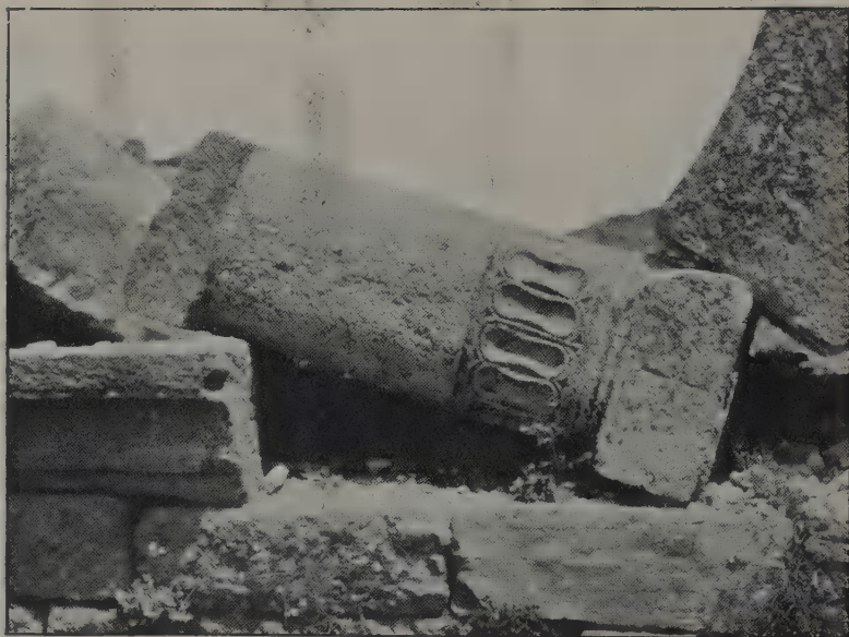
FIG. 180.—No. 32, column in nave.
